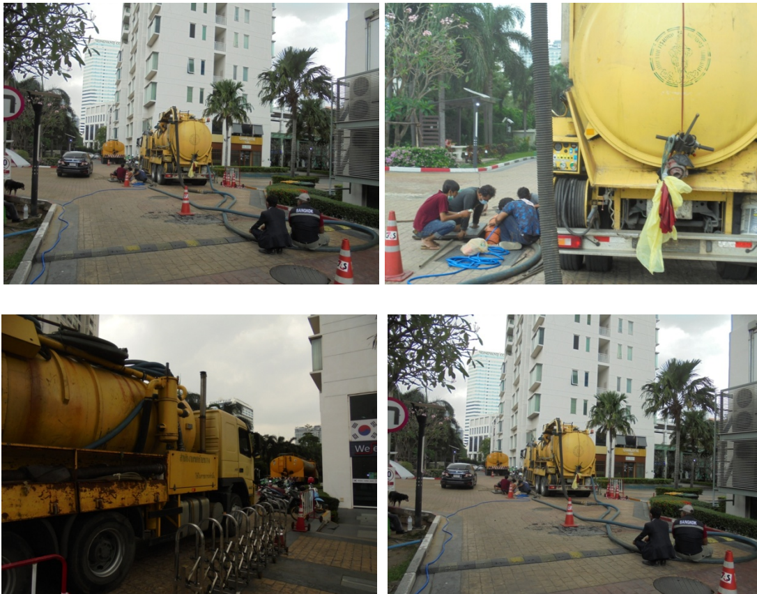
ภาพที่ 3-38 การสูบล้างปฏิภาณในบ่อเกรอะ
