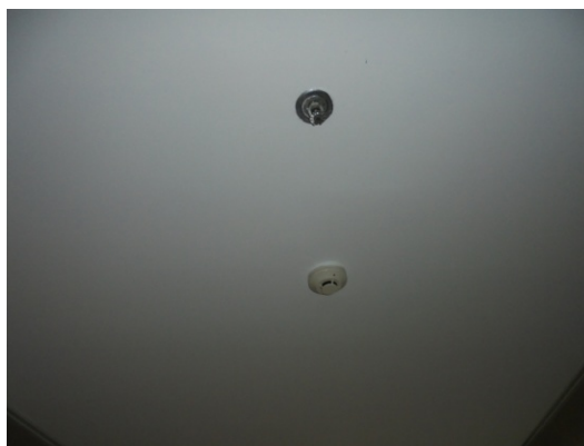
ภาพที่ 3-31 เครื่องตรวจจับควัน
