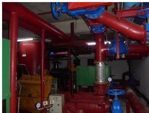
ภาพที่ 3-17 ห้องปั๊มน้ำและปั๊มสูบน้ำดับเพลิง
