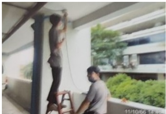
ภาพที่ 3-49 ช่างอาคารแก้ไขเปลี่ยนหลอดไฟในดวงโคมที่ชำรุด
