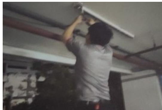
ภาพที่ 3-49 ช่างอาคารแก้ไขเปลี่ยนหลอดไฟในดวงโคมที่ชำรุด
