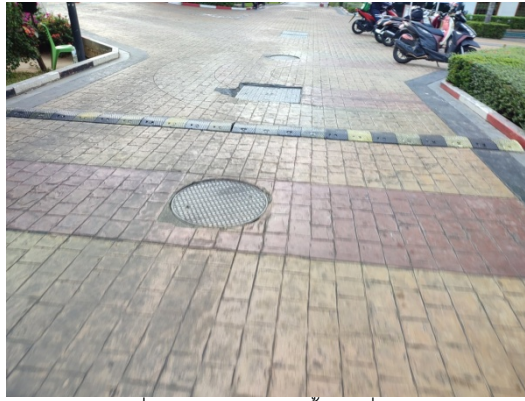
ภาพที่ 3-10 ฝาบ่อบำบัดน้ำเสียที่ปิดสนิท
