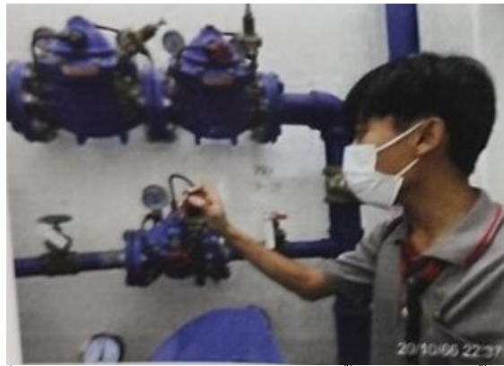
ภาพที่ 3-51 ช่างอาคารตรวจสอบวาล์วลดแรงดันน้ำ ระบบการจ่ายน้ำประปา
